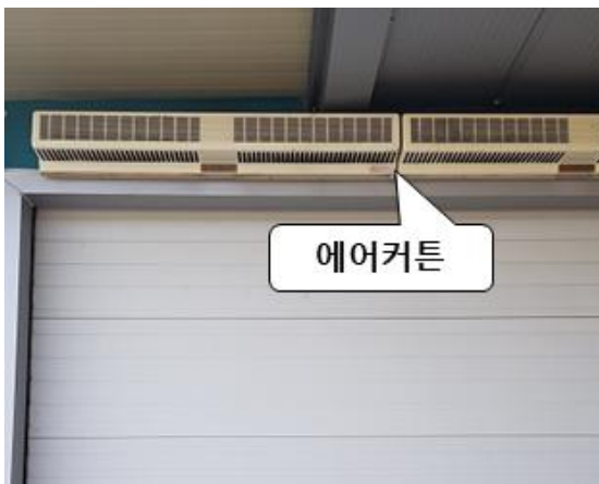
외부 출입문에 에어커튼 설치
